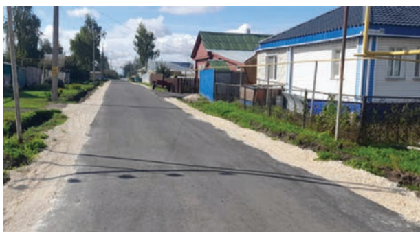
Рис. 31. Проект «Ремонт автомобильной дороги в с. Порецкое Порецкого муниципального округа Чувашской Республики – 2 этап»
