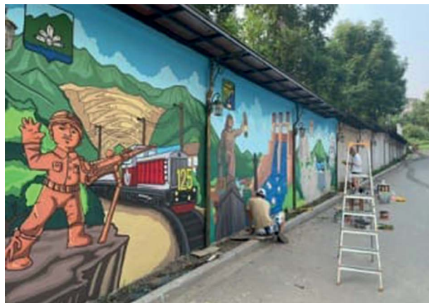
Рис. 35. Ремонт стены и создание мурала «12 городов Приморья и их достопримечательности», мкр. поселок Врангель, г. Находка, Приморский край
