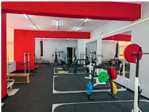
Рис. 126. Ремонт тренажерного зала в МКУ «Калининский культурно-досуговый центр»
